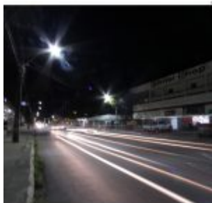
Nova iluminação da Avenida Carlos de Lima Cavalcanti.
