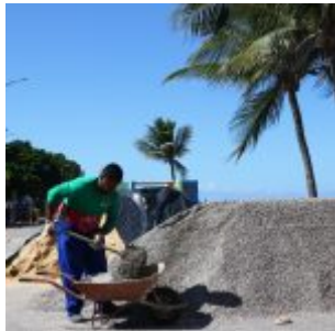
Trabalho na calçada da orla de Olinda. Foto: Júlio Santos / PMO
