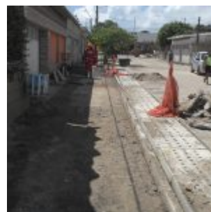
Drenagem em andamento. Foto: Secretaria de Obras de Olinda
