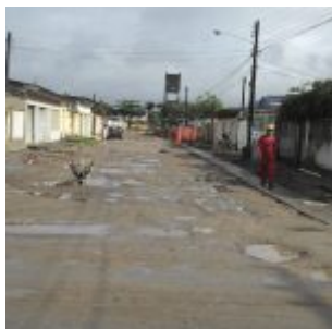
A Rua Amazonas antes de passar por obras. Foto: Secretaria de Obras de Olinda
