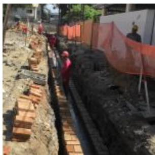
Drenagem sendo feita na Rua Amazonas. Foto: Secretaria de Obras
