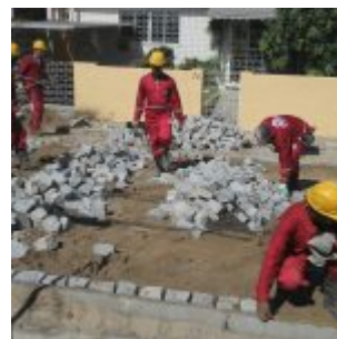
Pavimentação. Foto: Secretaria de Obras de Olinda
