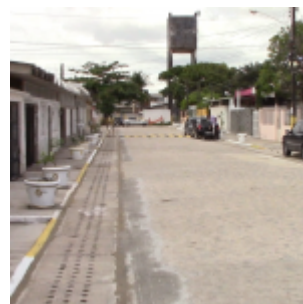
Rua Amazonas pronta. Foto: Rodrigo Barradas/Pref.Olinda
