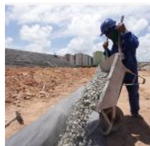
Obras do Estádio Grito da República. Fotos: Luiz Fabiano/ Pref. Olinda
