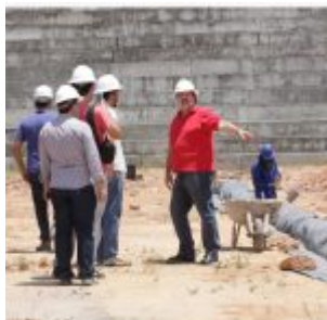
Obras do Estádio Grito da República. Fotos: Luiz Fabiano/ Pref. Olinda
