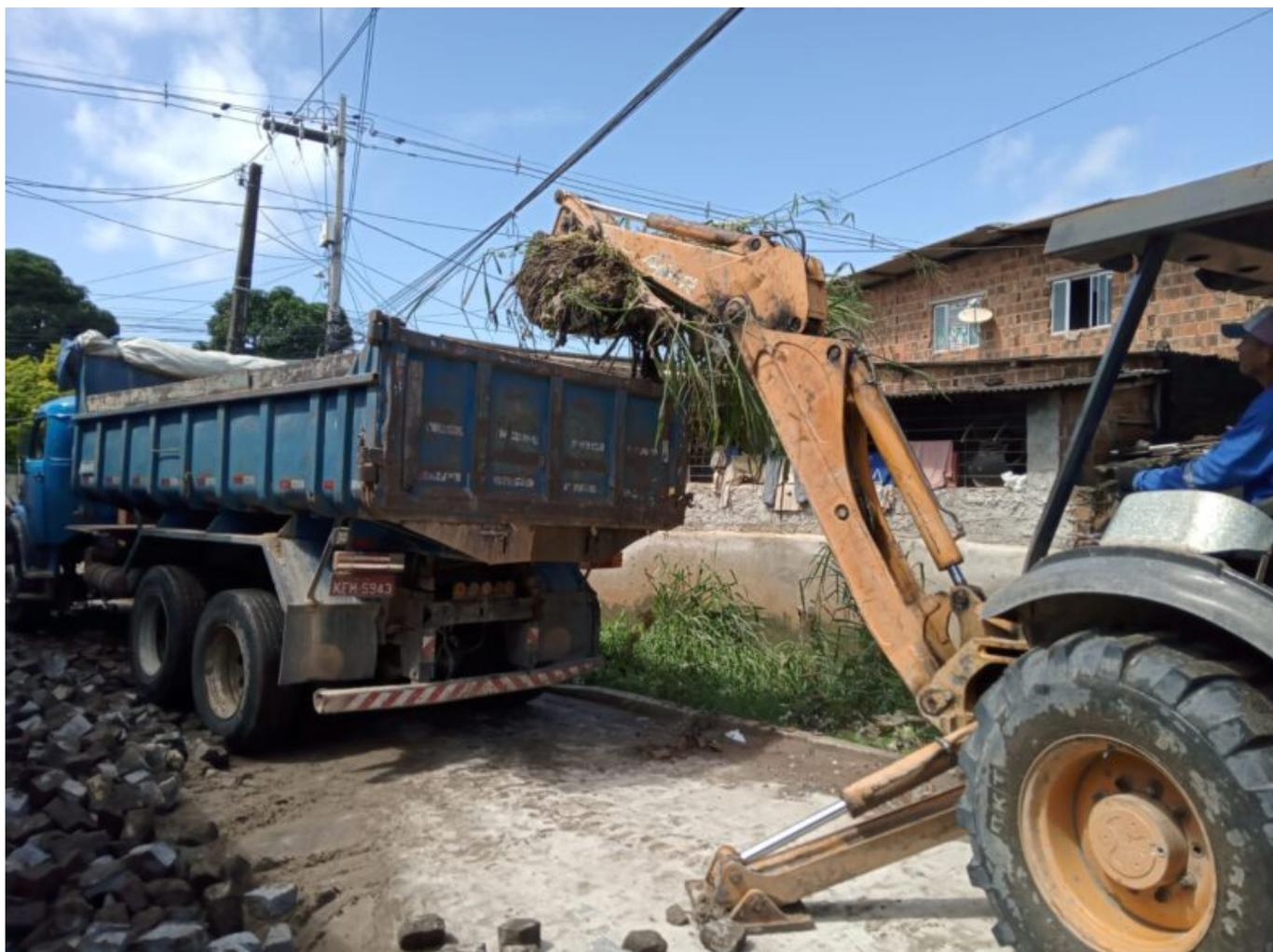
Trabalho envolve desobstrução de canais, remoção de entulhos de vias e retirada de detritos do sistema de drenagem
