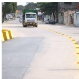
O trecho recuperado fica no início da Perimetral, próximo
