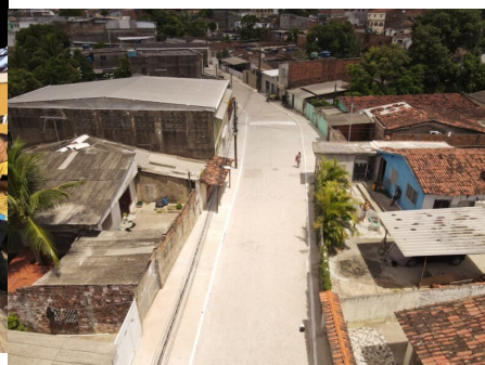
Rua Bogotá é inaugurada após obra de requalificação em Sapucaia
