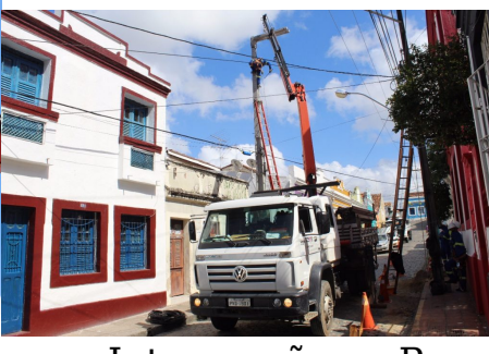
Intervenção na Rua do Bonfim. Foto: Anderson Olinda/PMO
