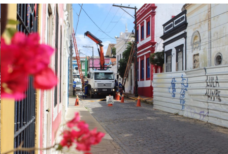
Intervenção na Rua do Bonfim. Foto: Anderson Olinda/PMO
